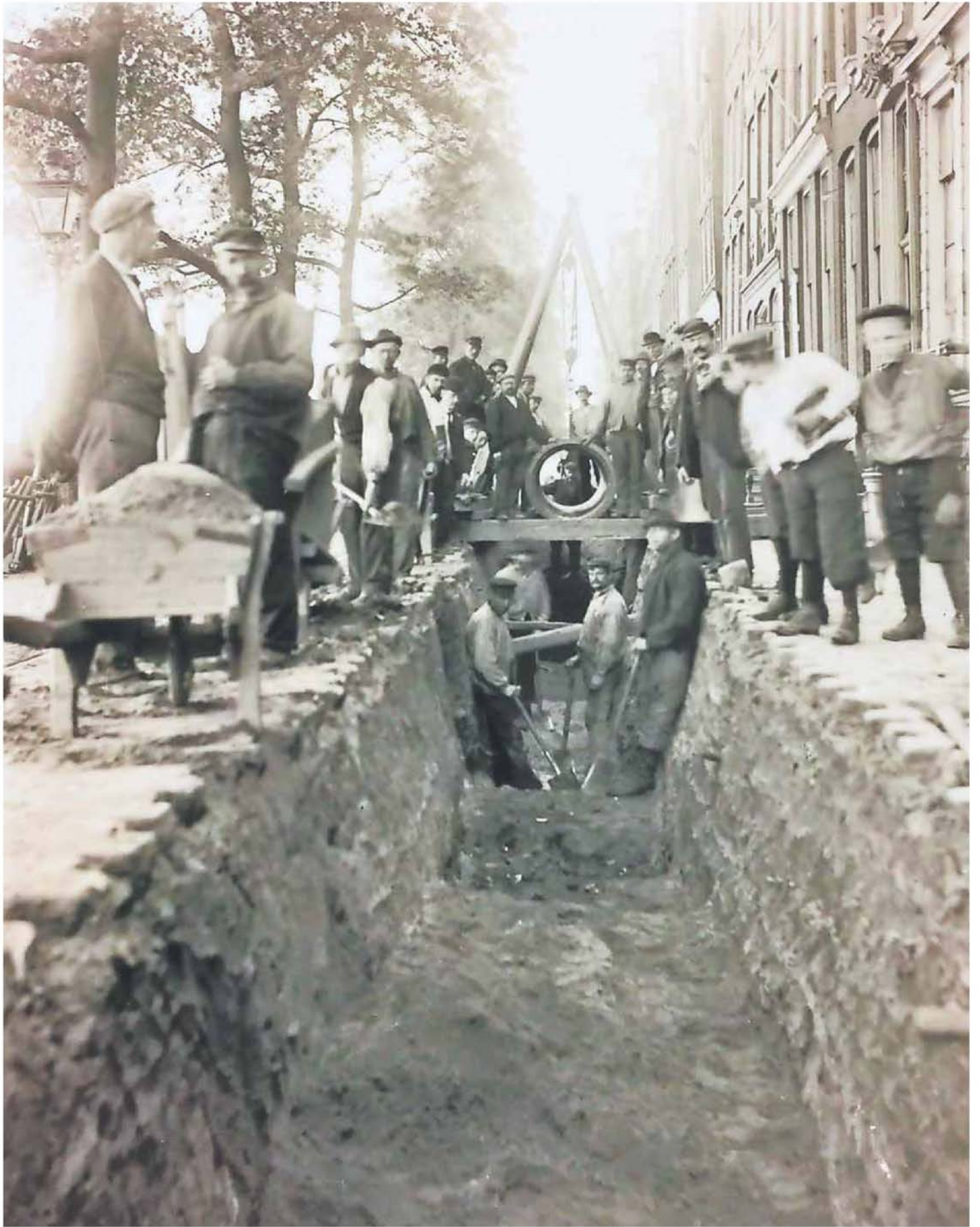
Het aanleggen van waterleidingen gebeurde vroeger nog met de hand.
